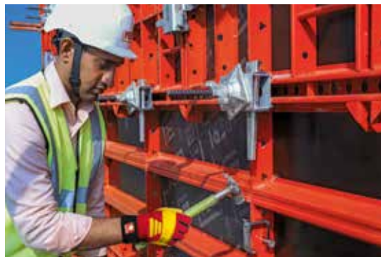
Un clip de calage et une pince d'alignement sont fournis pour raccorder efficacement et à moindres coûts les coffrages, en fonction des exigences données.
