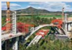
Coffrages de ponts
