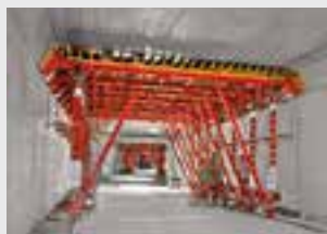
Coffrages de tunnels
