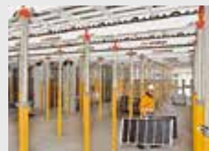
Coffrages de dalles
