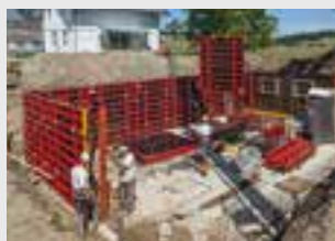
Coffrages de voiles
