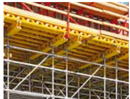
L'utilisation de la poutrelle GT 24, en tant que primaire double en liaison avec un étaielement PERI UP Rosett Flex, permet la reprise de charges élevées sur de grandes hauteurs.
