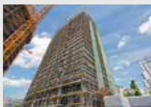
Echafaudages de façades
